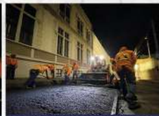
BACHEO DE VIAS PAVIMENTADAS
