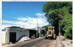
CONFORMACIÓN DE CALZADA
