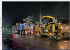
PERFILADO Y COLOCACIÓN DE CARPETA ASFÁLTICA
