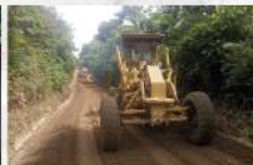
REPOSICIÓN DE CAPA DE BALASTO
