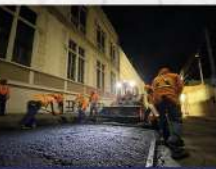
BACHEO DE VIAS PAVIMENTADAS
