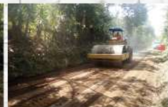
REPOSICIÓN DE CAPA DE BALASTO
