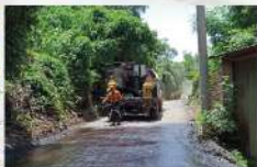
COLOCACIÓN DE IMPRIMADO CON EMULSIÓN ASFÁLTICA
