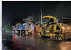
PERFILADO Y COLOCACIÓN DE CARPETA ASFÁLTICA
