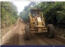
REPOSICIÓN DE CAPA DE BALASTO
