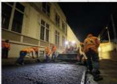
BACHEO DE VIAS PAVIMENTADAS
