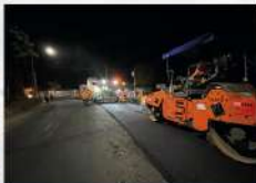
PERFILADO Y COLOCACIÓN DE CARPETA ASFÁLTICA
