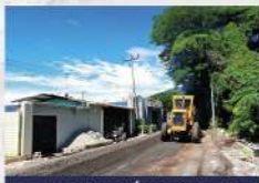
CONFORMACIÓN DE CALZADA
