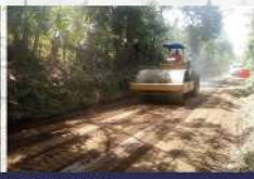
REPOSICIÓN DE CAPA DE BALASTO
