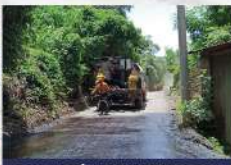
COLOCACIÓN DE IMPRIMADO CON EMULSIÓN ASFÁLTICA
