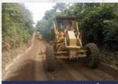
REPOSICIÓN DE CAPA DE BALASTO
