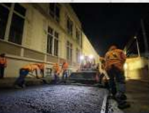
BACHEO DE VIAS PAVIMENTADAS
