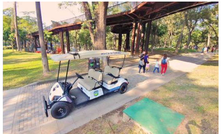
Pasarela elevada peatonal y área de ciclovías.
