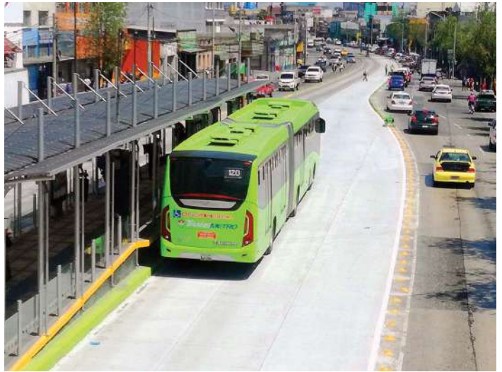
Fuente: Municipalidad de Guatemala. Una de las 220 unidades articuladas del sistema Transmetro en la línea 12 de Transmetro, operado con autobuses de la marca Volvo, euro 5 y detalle de vías exclusivas con rodadura de concreto de alta resistencia y separadores de carriles en forma de boyas frente a estaciones para permitir entradas y salidas de vehículos de emergencia y al fondo segregadores de carril tipo bordillo de concreto para evitar intrusión de vehículos.
