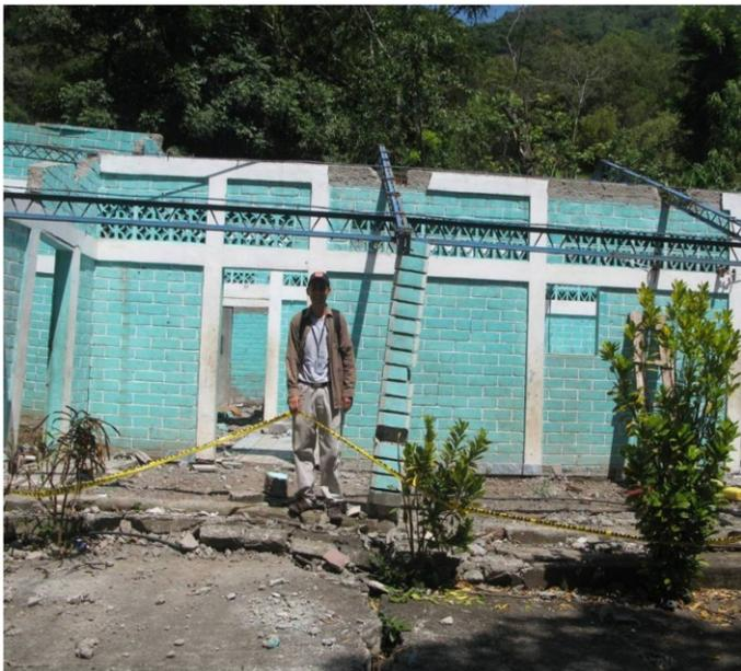
Figura 6 Daños severos ocasionados por el movimiento traslación a las viviendas de la zona B
